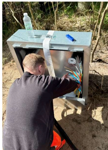
FIGUR 1 KLARGØRING AF FIBERSKAB PÅ FYNSHOVED
