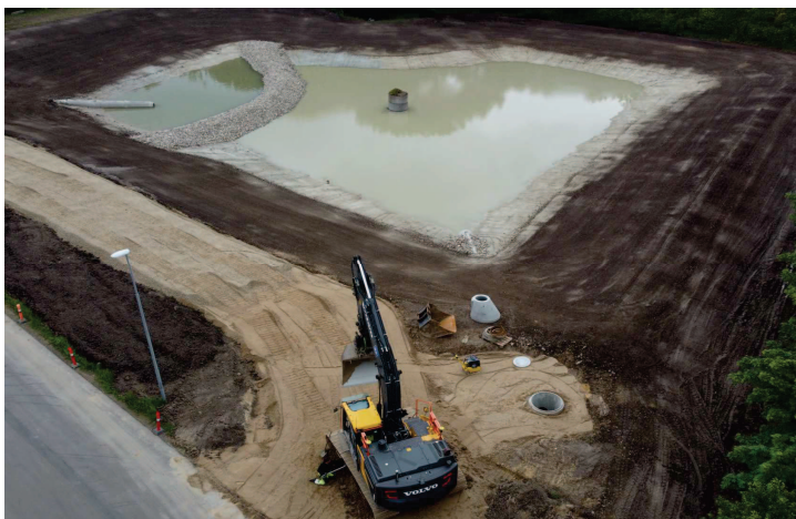
Foto fra anlægsarbejdet vedr. etablering af regnvandsbassin i Skjoldborg
