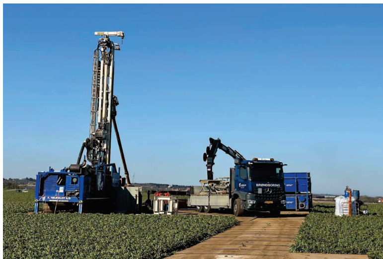
Foto fra brøndboring ved potentiel ny kildeplads i Snedsted/Hørsted
