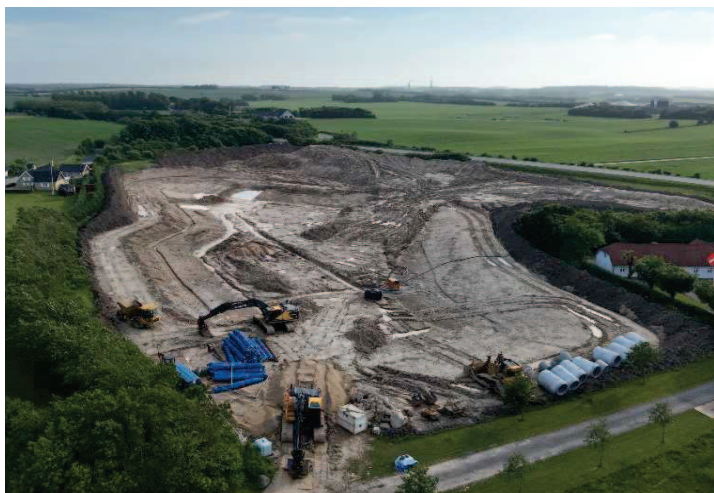
Foto fra anlægsarbejdet vedr. etablering af regnvandsbassin i Silstrup
