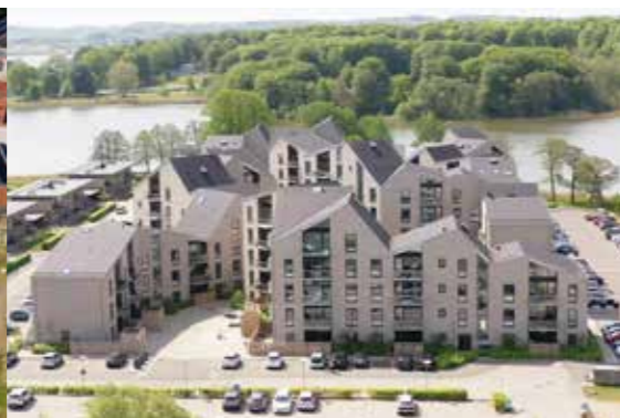
Ovenvande omfatter 128 boliger på i alt 13.540 m 2 og er opført med bærende konstruktioner i betonelementer og med listepaptag. Projektet er opdelt i 2 etaper og opført for 2 forskellige bygherrer.
