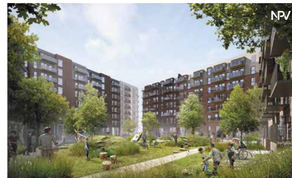
I tæt samarbejde mellem NPV, HLA og Sweco er Gammel Havn projektet blevet gennemarbejdet og gjort bygbart. Som resultat af et godt samarbejde er 3 projekter i første af flere etaper nu under opførelse.
