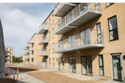
Englund i Rødovre 100 lejligheder og 21 rækkehuse samt P-kælder. For AEP.
