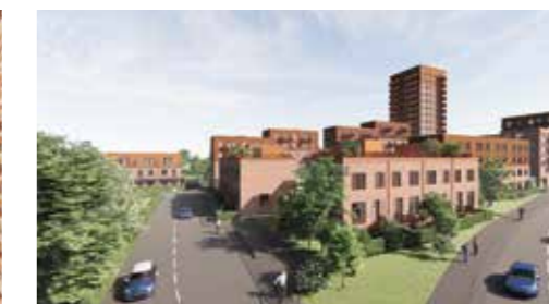
Grønnebro i Hvidovre 171 boliger. Fire etagebebyggelser, otte rækkehuse og et højhus. AKF Holding er bygherre.
