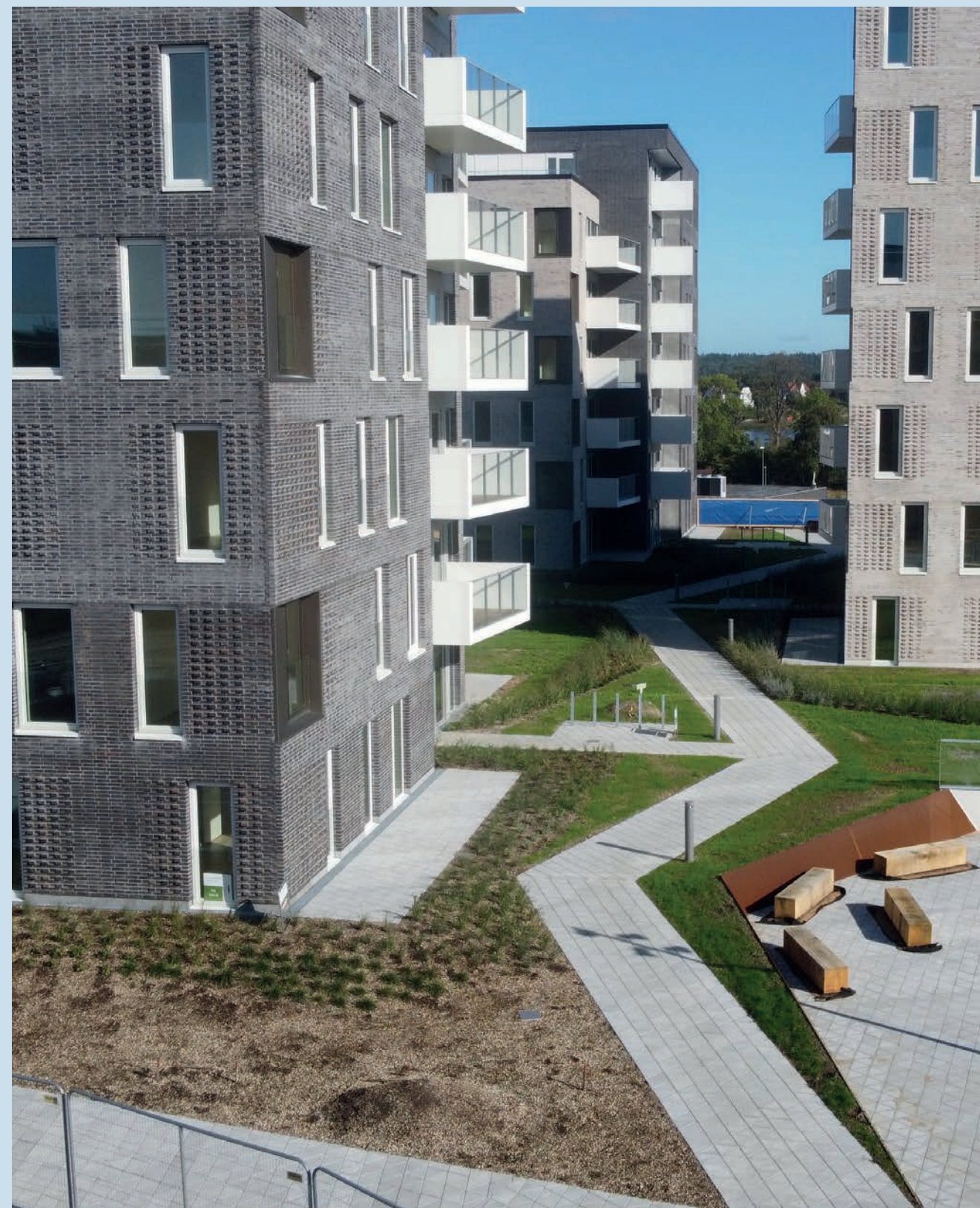
I det forgangne år blev fase 1 og 2 af det store Sotorvet projekt i Silkeborg taget i brug
