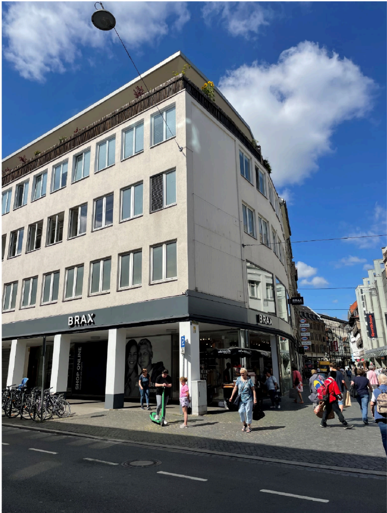
Ejendommen Braunschweig Münzstrasse
