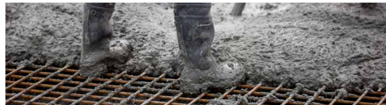
Støbning af fundament på PensionDanmarks byggeri af Kronløbsøen i København
