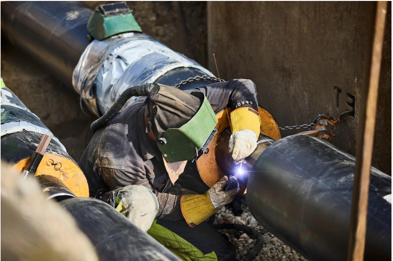
Anlægsarbejder ved Selsmosen
