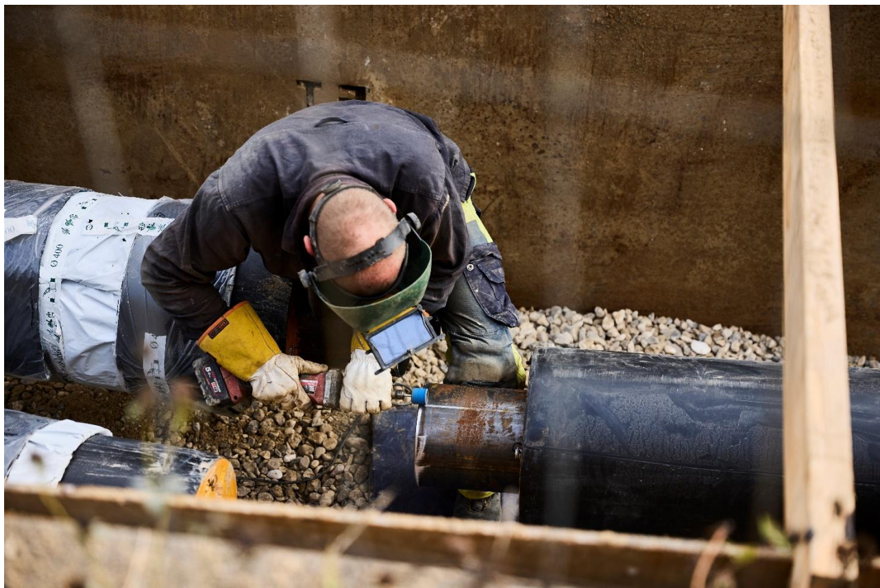
Klar til svejsning af rør
