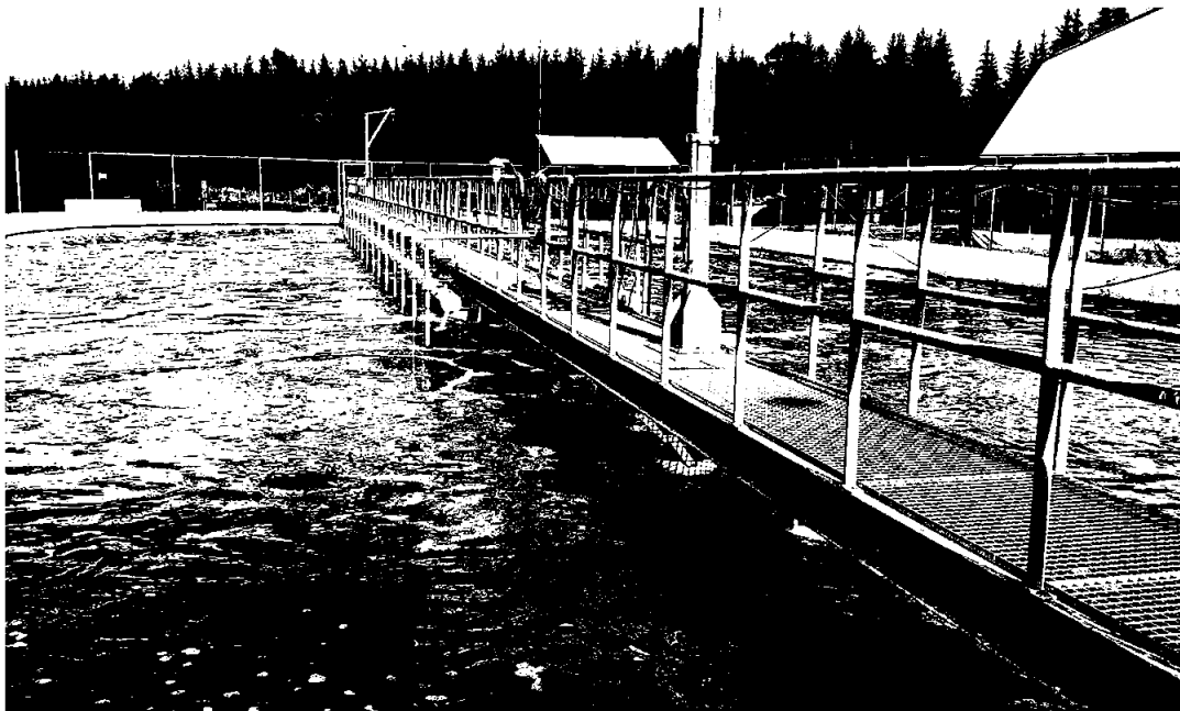
Renseanlegget har hatt stabil og god drift i 2022. Her er et bilde av luftebassenget. Foto: ØRAS
