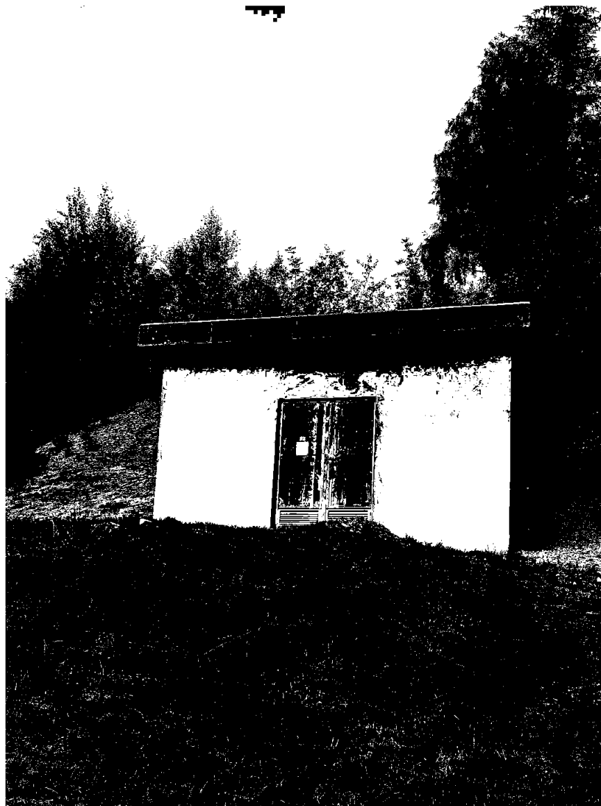
Nyoppussa nettstasjon i Røslbakkane Gaupne
