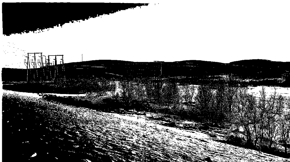
Bilde 1 Smørfjord stasjon
