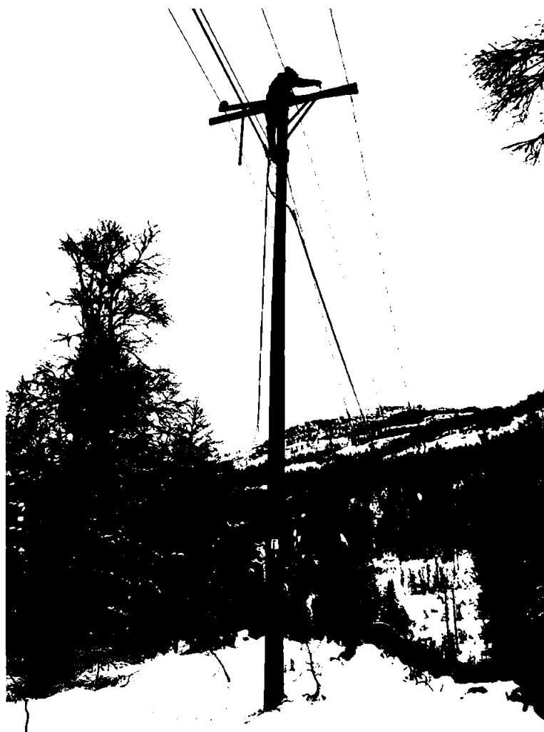
Arbeid i mast
