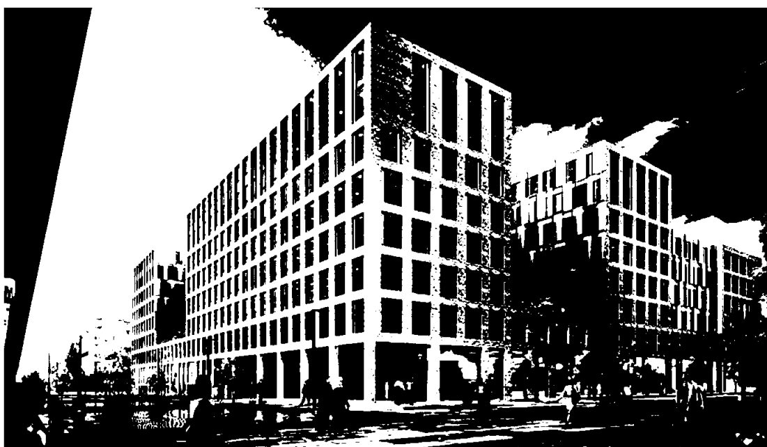
Hoffmann bygger kontorbygg på Kay Fiskers Plads i Ørestad ved København for KLP Ejendomme.
