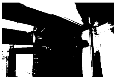
Bildet viser elektrisk dørpumpe.
