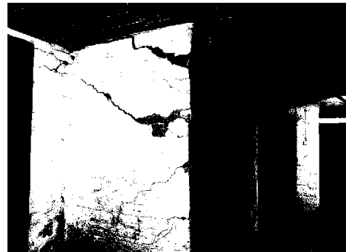
Store skader i kjeller
