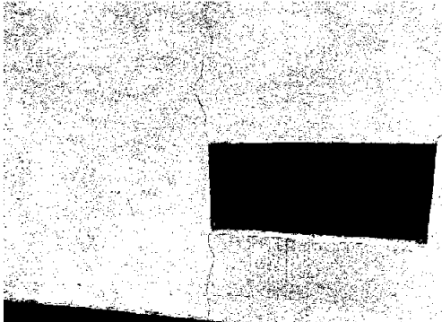
Riss i murpuss
