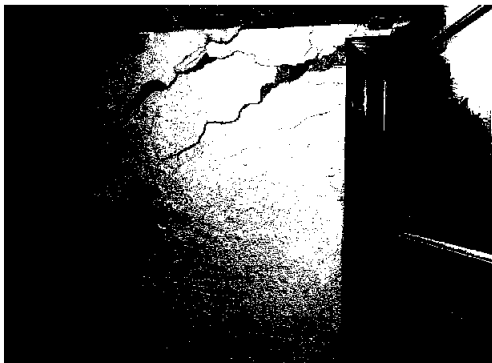
Omfattende sprekker i delevegger
