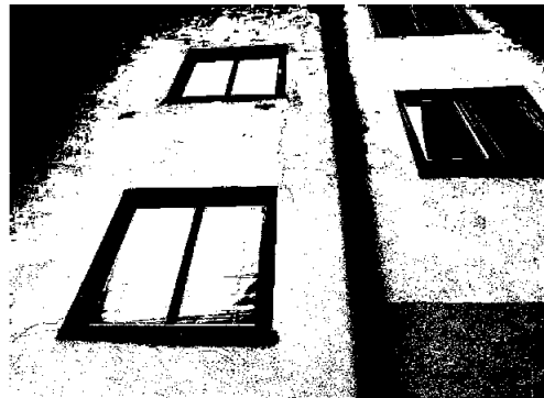
Vinduer av ulik alder, tilstand og utførelse
