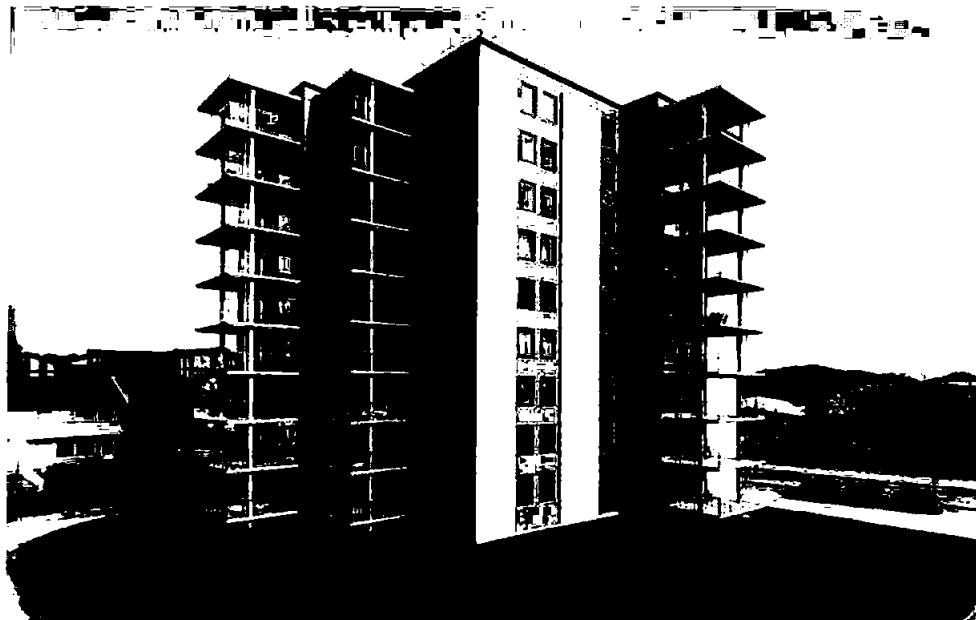
BORETTSLAGET ST. OLAVSVEI 33
