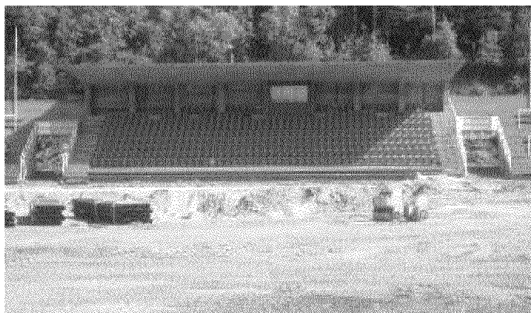
Oppgradering av hovedbanen på Narvik Stadion.
