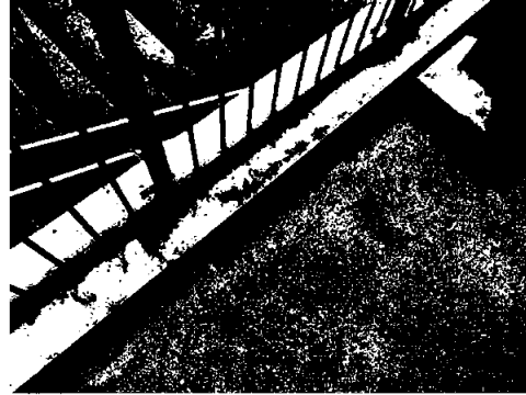
Rist må legges på plass. Gjelder flere
