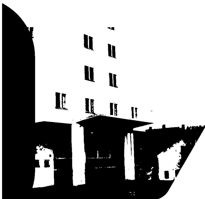
Kommottak før ombygging i 79-81
