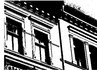
Begrunnelse PV (per. vedlikeh)
