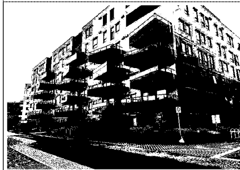
Bilde nr. 4 Fasade øst.
