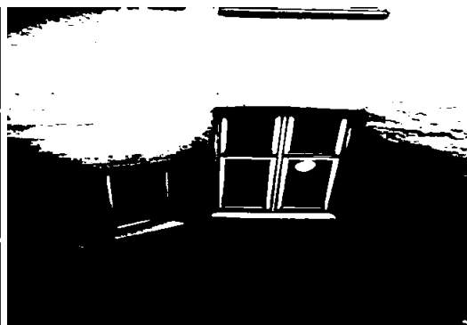
Mindre en 2 meter mellom seksjoner, fare for brannsmitte.
