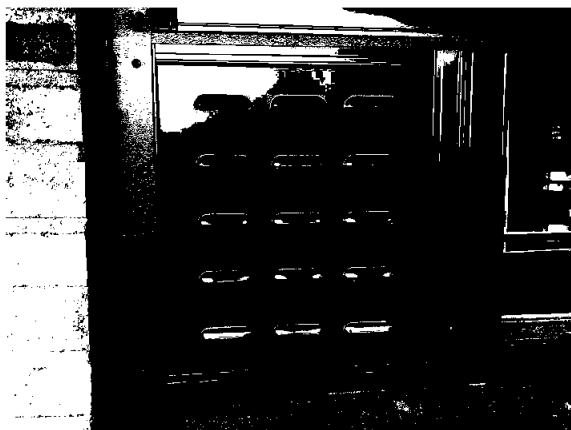
Bilde 1 og 2: Arealet på lufteluken er oppgitt til å være ca. 33x37cm innvendig åpning iht. rapport fra Opak.
