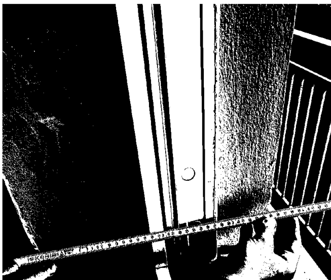
Figur 2 – Bilde tatt på befaring av vindu ut mot brannbalkong
