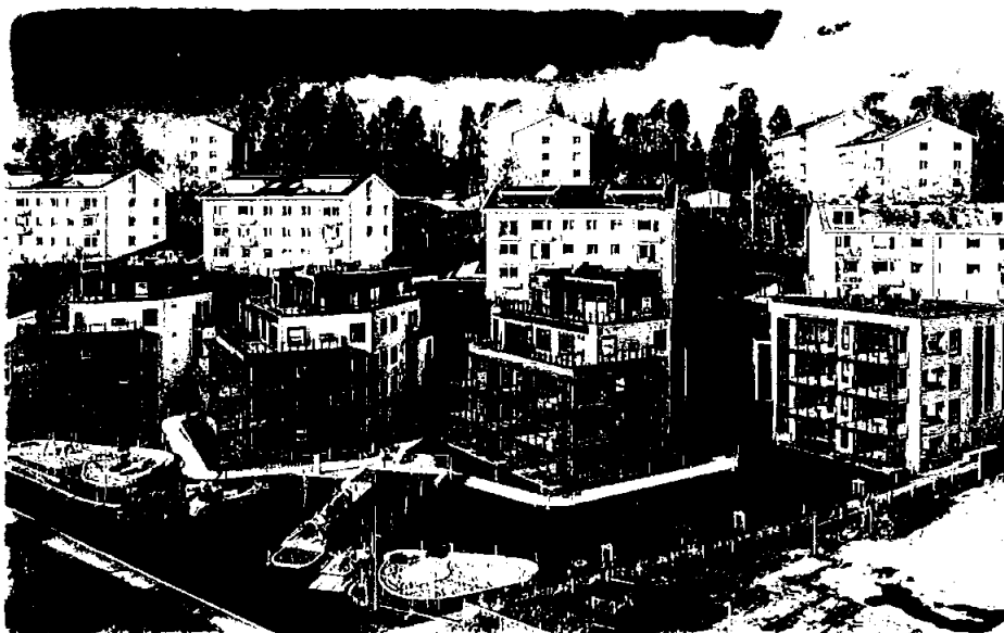
Holtekilen Front, Oksenøya/Fornebu. 40 leiligheter fordelt på fire blokker over felles parkeringskjeller. Overlevert november 2020.
