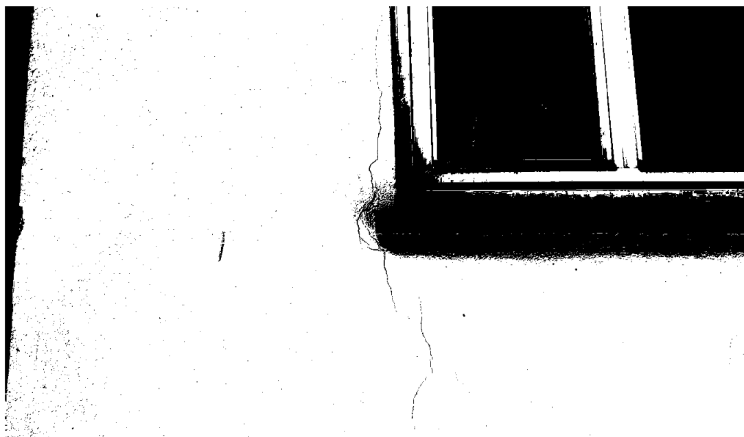
Riss og bom i murpuss
