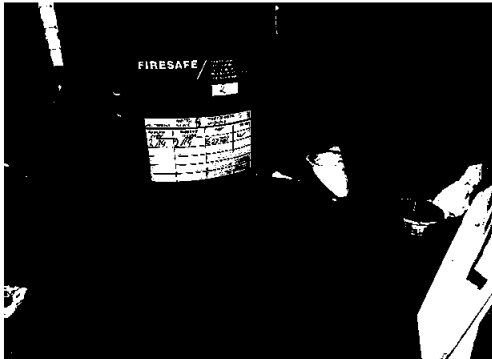
Brannslukningsutstyr må kontrolleres, merkes og henges på brakett
