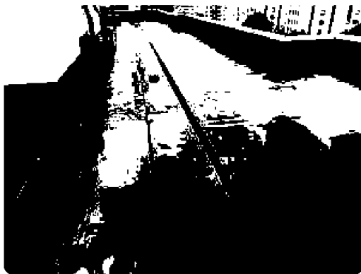
Fall til renne og innvendig nedløp
