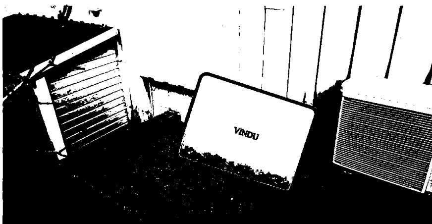
Figur 1 – Nytt vindu for rømningsvei i kjeller.
