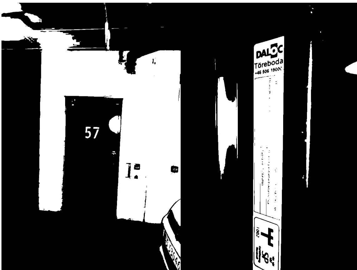
Brannjør i brannskillende konstruksjon.
