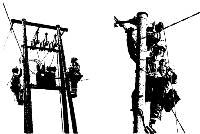
Bilde 1 Vedlikeholdsarbeid på distribusjonsnett i Porsanger og Havøysund.
