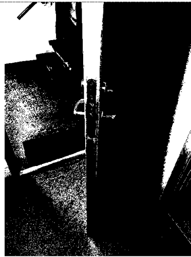
Bilde 4: Dør fra sluse mot trapperom går ikke igjen pga. setningskader i 20B
