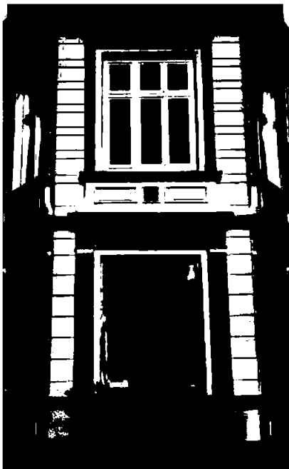
Ulovlig vindusutskifting. Her ser vi tydelig hvordan fasaden endrer karakter etter at man har skiftet det opprinnelige vinduet med en dårlig kopi.
