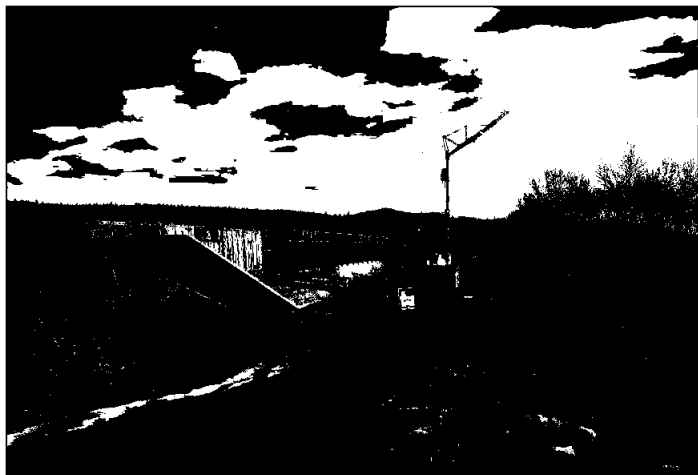
Flyvatn. Plastring dam øst, og betongarbeider på overløp Foto: Øyvind Eidsgård
