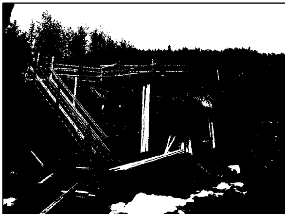
Fasle elv. Reparasjon av bjelkestengsel. Foto: Øyvind Eidsgård
