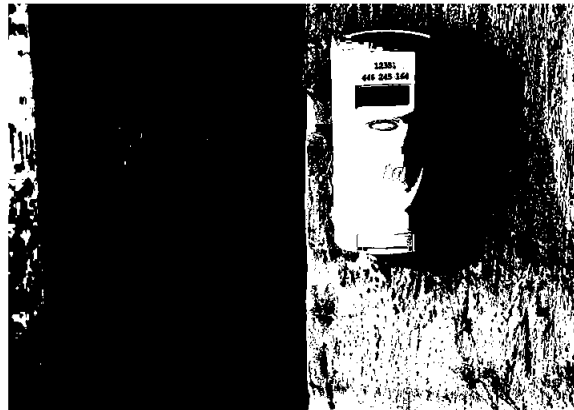
T-loggeren er velegnet til plassering for eksempel i kjeller-, lofts- eller vaskerom hvor det er ønske om å holde en lavere temperatur enn i leiligheter. Foto: ista
