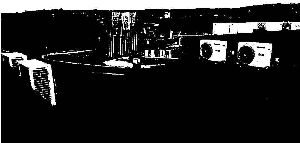
I dette borettslaget har Trønderservice montert 12 varmepumper. Utedelene er plassert på taket, og rørføringer er samlet og skjult bak bilkk.
