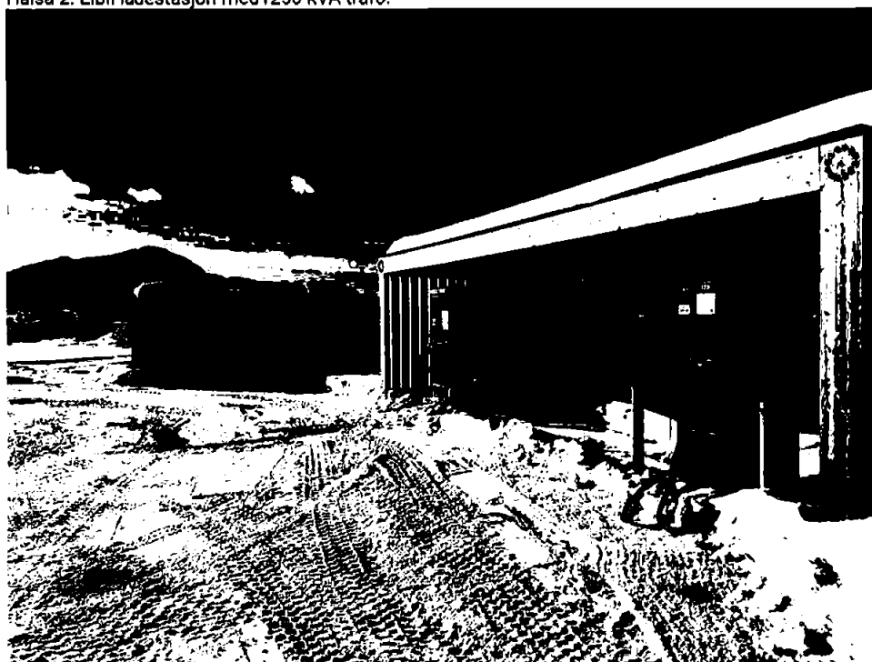
Ørnes 6. Elbil ladestasjon med 1250 kVA trafo.
