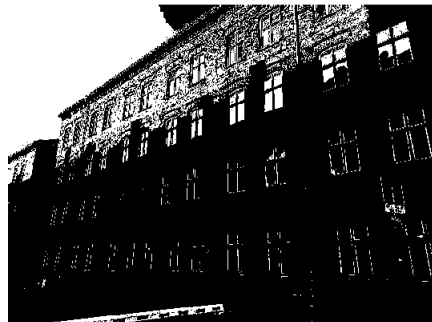
Bildet viser fasade mot Tøyengata.
