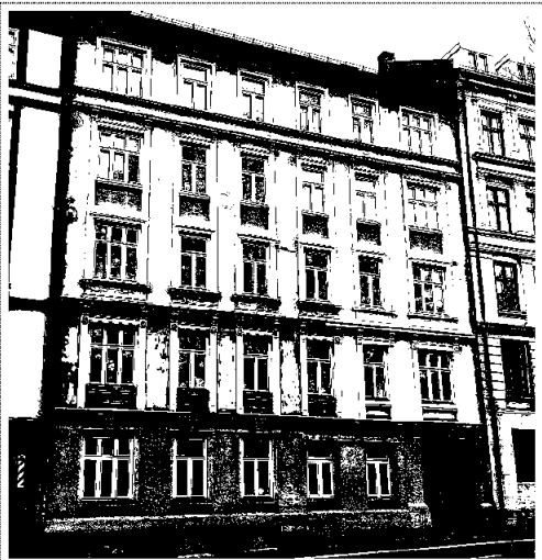
Bilde nr. 1 Fasaden mot Uelands gate hugges ren, innfestning til utsmykning kontrolleres, ny oppbygging med pussjikt og maling.
