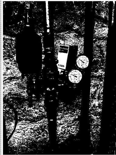
Bilde nr. 36 Sprinkelsentral i kjeller
