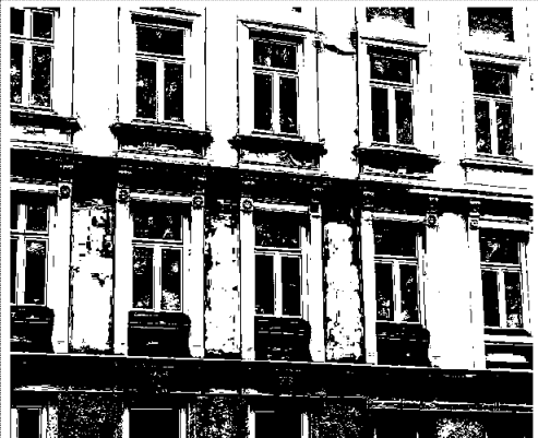
Bilde nr. 3 Fasaden mot Uelands gate hugges ren, innfestning til utsmykning kontrolleres, ny oppbygging med pussjikt og maling.
