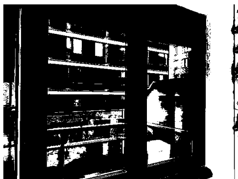
Vindu beslått med lakkert aluminium
