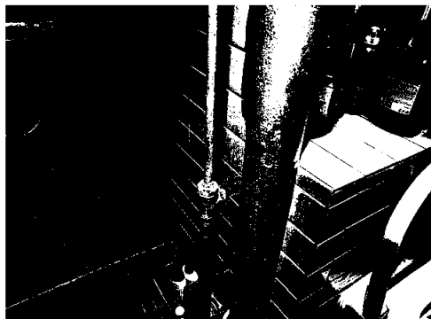
Vannrør, trolig fra byggeår
