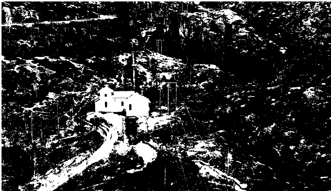
Biletet syner Tveitafoss Kraftstasjon. Stasjonen vart riven i 2024, og HE bygger ny kraftstasjon som skal stå ferdig i mars 2026.
