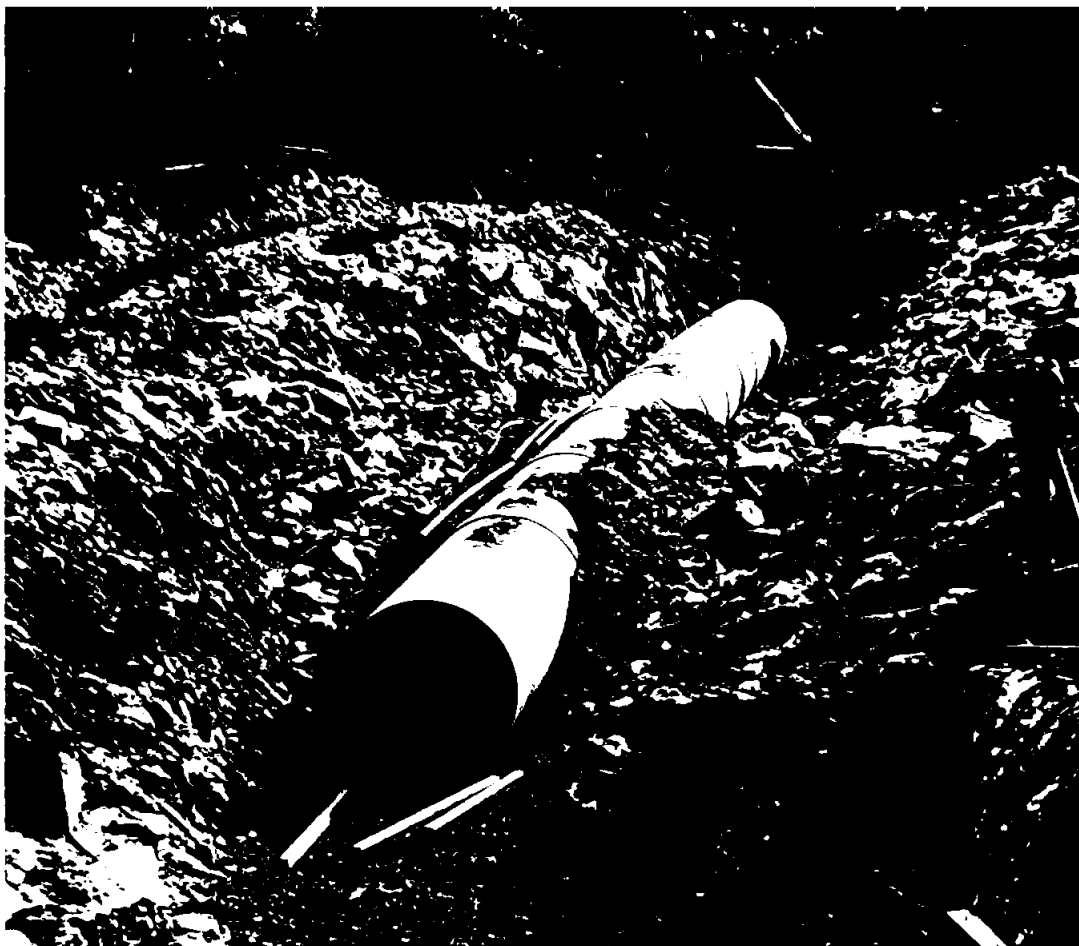
Legging av ny rørgate til nye Tveitafoss Kraftverk
