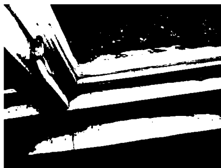
Vindu med vedlikeholdsbehov
