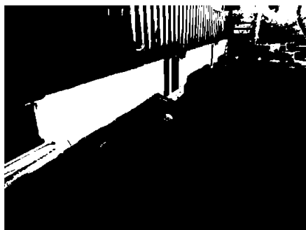
Utvendig fuktsikring
