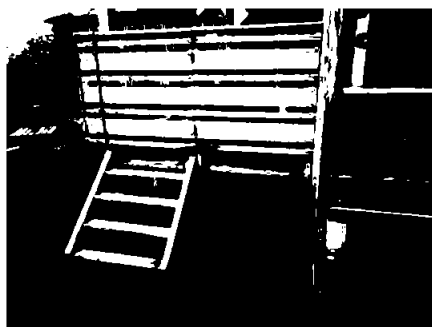
Trapp til balkong
