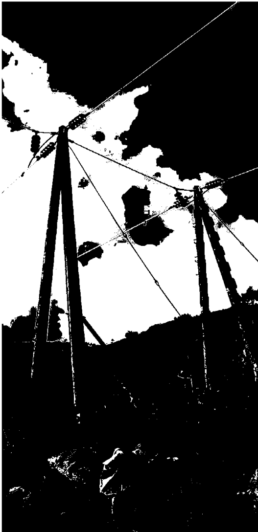
Linjen mellom Opstveit og Uskedalen er en viktig del av kraftlinjenettet i dette området, og oppgraderingen har økt både leveringskapasiteten og forsyningsikkerheten til rundt 5 000 strømkunder i området.
