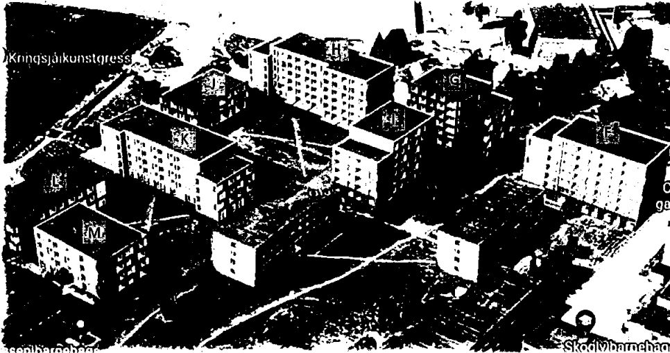
Kringstjå byggetrinn 3, Sognsvann - Oslo. Bedriftens største kontrakt hittil og gjelder oppføring av ca 580 studentboliger fordelt på åtte nye bygg. Byggestart var i august og prosjektet vil pågå til våren 2025. Totalentreprise verdt over 820 MNOK inkl. mva inkl. opsjoner.
