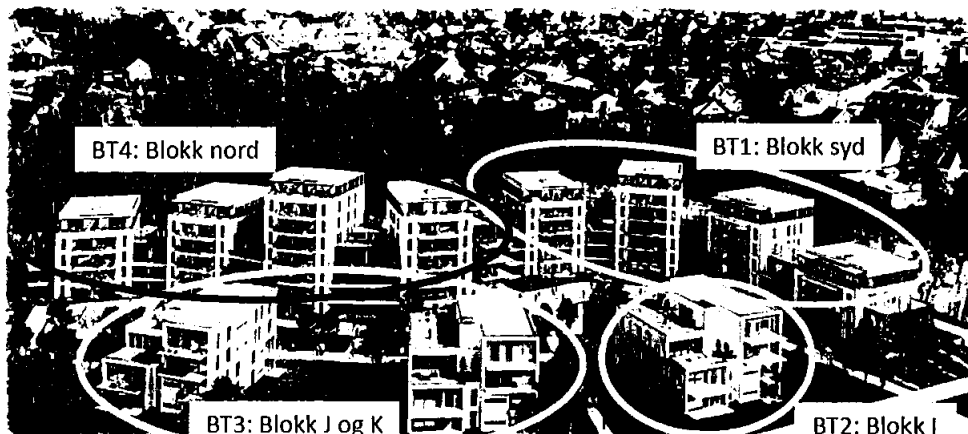
Tindlund Park, byggetrinn 4 - blokk nord, 73 leiligheter over felles parkeringskjeller. Overleveres i juni 2023.
