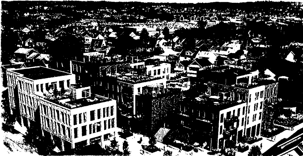
Gressvik Torg, Fredrikstad. Nytt handelssentrum med bolig, handel og kontor. Totalvolum ca 16.750m 2 BTA. Kontrakt ble signert 31. mars 2023, og riving av eksisterende bygningsmasse ble påbegynt i april. Overleveres sensommeren 2025.
