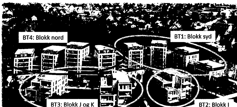
Tindlund Park, byggetrinn 4 - blokk nord, 73 leiligheter over felles parkeringskjeller. Overlevert i juni 2023.
