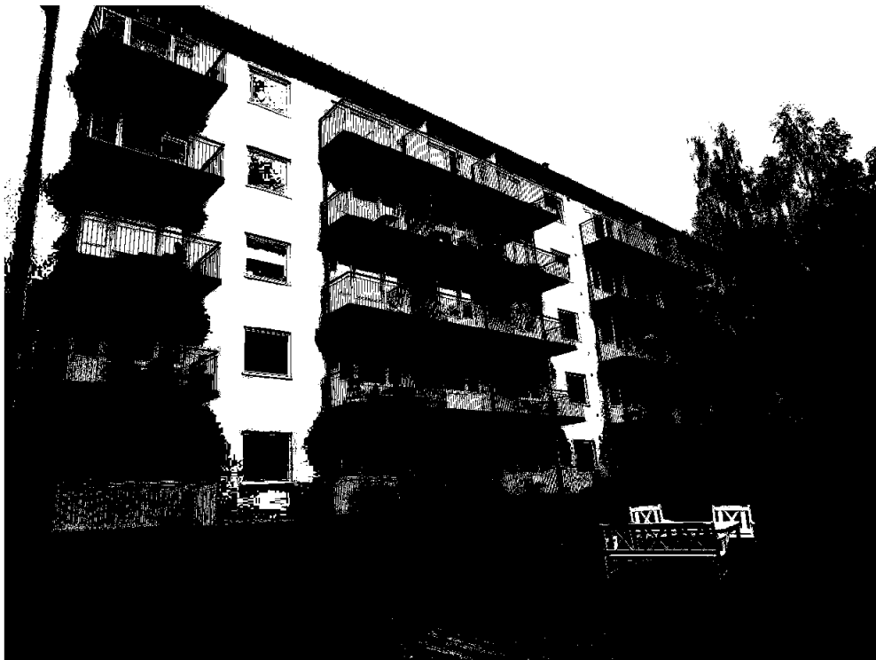
Treschow Terrasse A Oslo. Enkeltbalkonger og doble med åpningsbare glassvegger.
