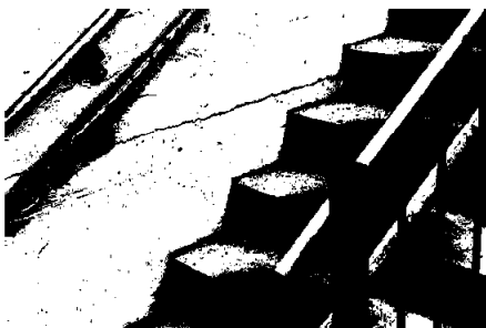
Manglende kontrastfarger på trinn og vegg
