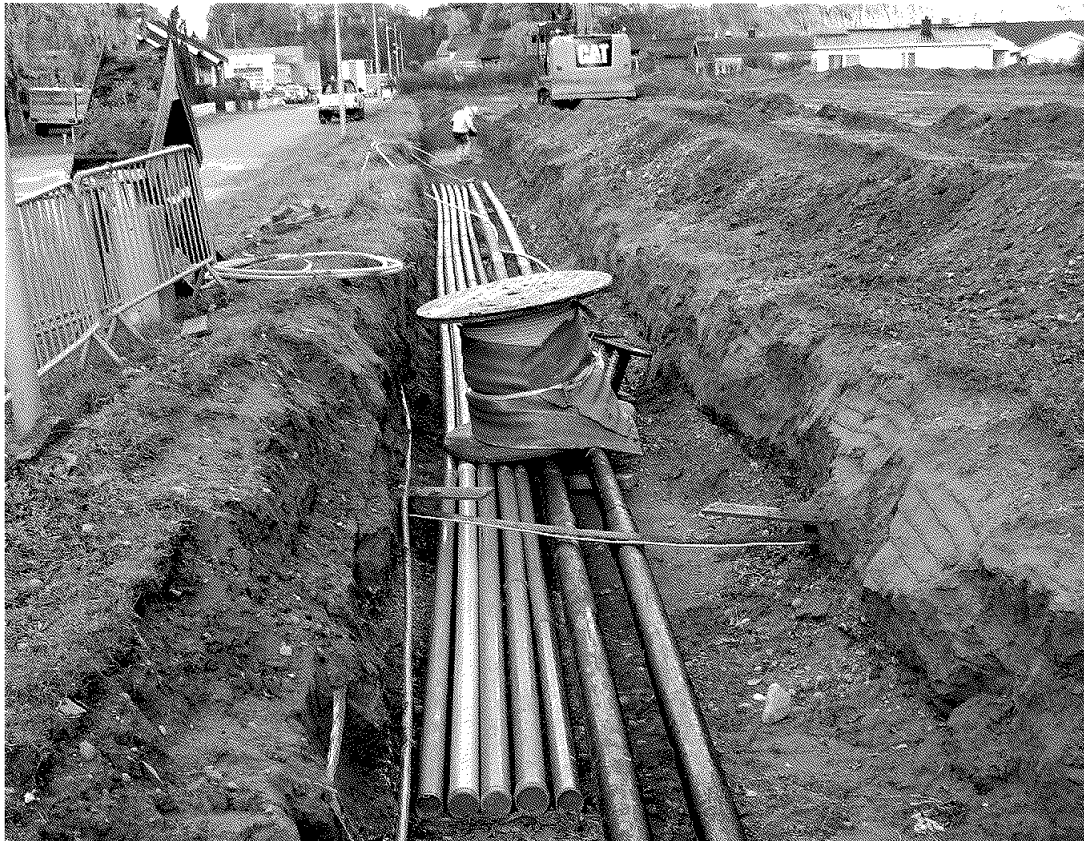
Fjernvarme og strøm i Langslågata. Foto A. Nedal
