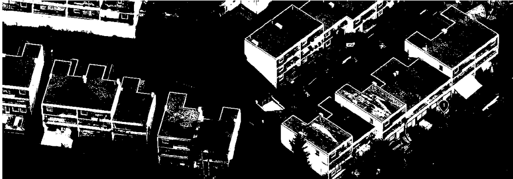
Skråfoto av borettslaget viser at rekkehusene i volum veksler mellom 2 og 3 etasjer også for samme bygningskropp.
