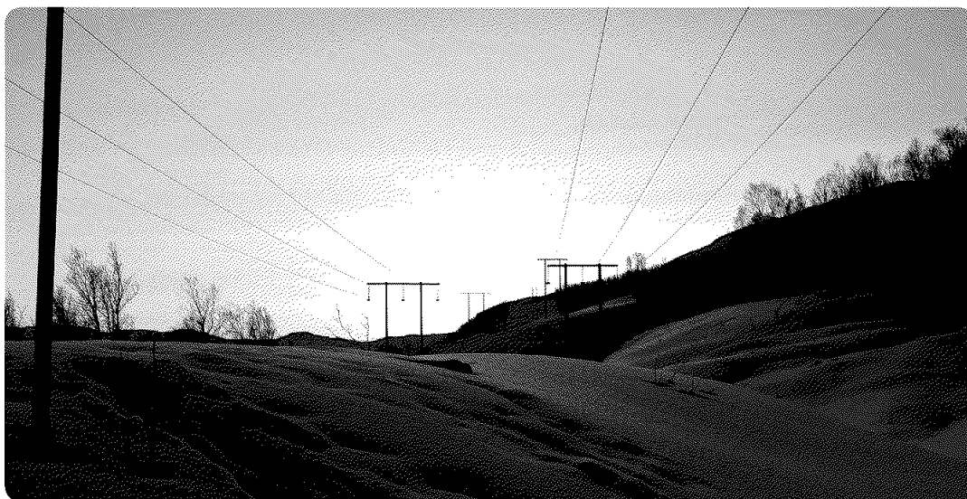
Nettpartner Prosjekt AS var leverandør til bygging av 66 kv-linje fra Storslett til Hamneidet. Bildet viser ferdig linje mellom Gjøvarden og Bakkeby. Foto: Lars Eirik Høgbakk
