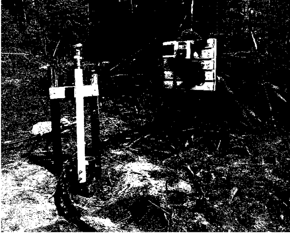
Figur 5. Den nye brønnen ved Finstad vannverk, med oppsett av pumpesystem.
