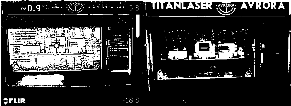
Vedlegg 2 Termografibilde av butikkfasade
